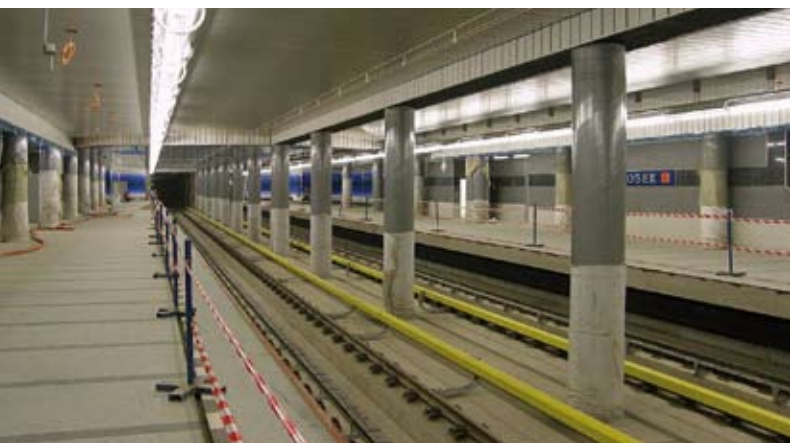
Estación Prosek – previo a la finalización de obra
