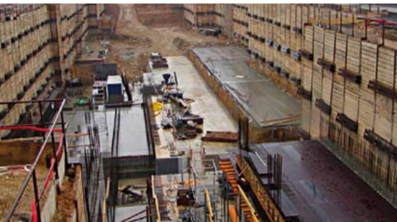
Estación Prosek - Excavación abierta
