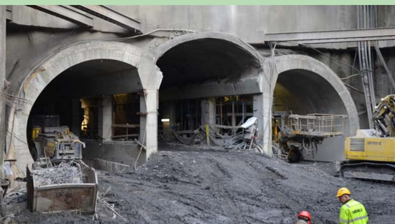
Portál trojlodní stanice metra Nádraží Veleslavín
