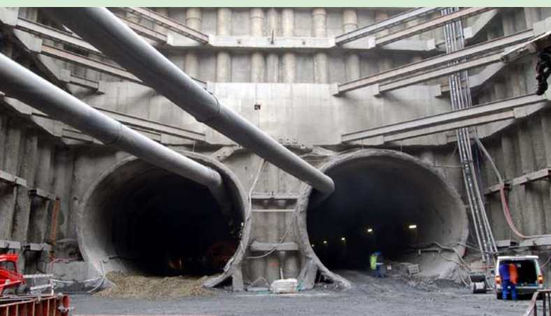
Ražba bočních staničních tunelů
