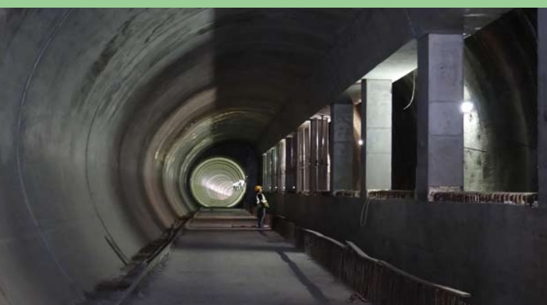
Definitivní ostění bočního staničního tunelu
