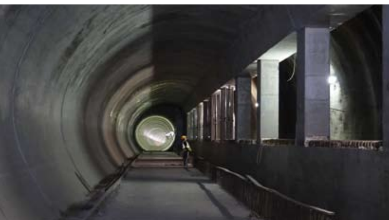
Revestimiento definitivo completado de un lado del túnel de la estación.
