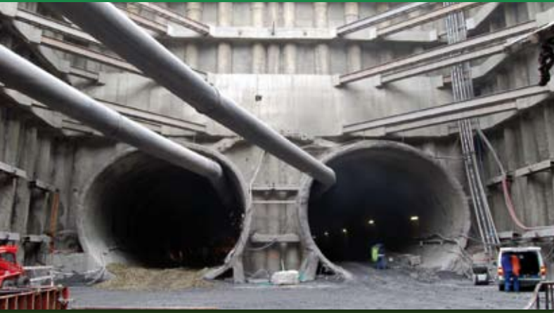
Excavación de los túneles de la estación
